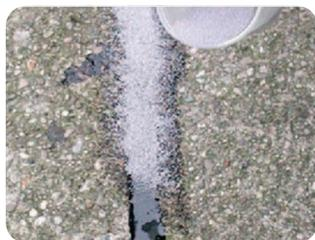
**BLACK SEAL 2K** indurisce per effetto della reazione tra i due componenti: in questa fase dell'applicazione, il prodotto diventa di colore nero opaco; è possibile cospargere di sabbia (dimensioni 0/4 mm) per aumentare la resistenza meccanica, la sicurezza stradale ma anche per dare uniformità alla pavimentazione, scegliendo una sabbia della stessa colorazione delle pietre utilizzate per realizzare la pavimentazione.
